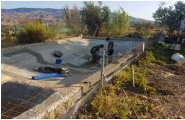
Después de 15 años de existencia la mayoría de las balsas necesitaban renovación profunda. After 15 years most of the ponds needed renovation as losing water from cracks.
